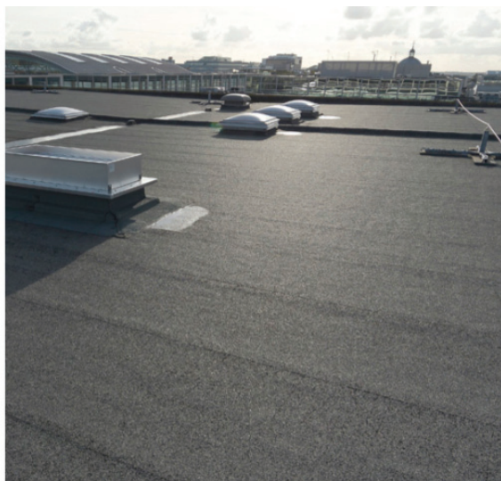
Figure VII-3 Exemple d'applicabilité industrielle de l'olivine pour la réduction du CO 2 atmosphérique issue du catalogue des produits et solutions de l'entreprise Derbergum® . https://derbigum.be/fr/etancheite/toiture-depolluante/
