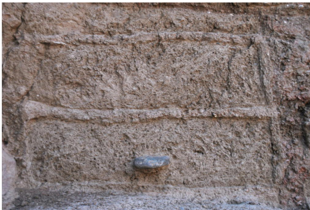
Figure 69. Erebuni . Briques d’adobe US 1430 avec l’ajout visible d’un dégressant végétal (traces visibles de «paille»). Cliché S. Deschamps, mission archéologique franco-arménienne Erebuni .
