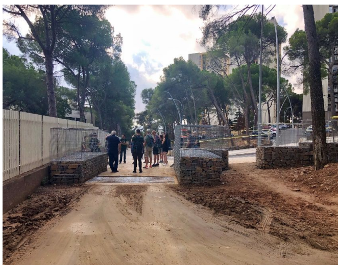
Photographie 1 : Limites physiques en lisière du parc entravant le passage des ongulés. De part et d'autre du passage canadien (à gauche), un mur en brique surplombé d'un grillage est muni d'une ouverture (à droite). Une porte conçue pour permettre la circulation humaine tout en évitant la sortie des animaux y sera installée. Barcelona, 7 septembre 2022, Carole Marin
