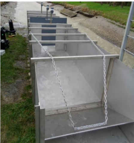
FIGURE 4.6 – Photo de la zone 4 du canal in situ , vue de l'aval. ©OFB.
