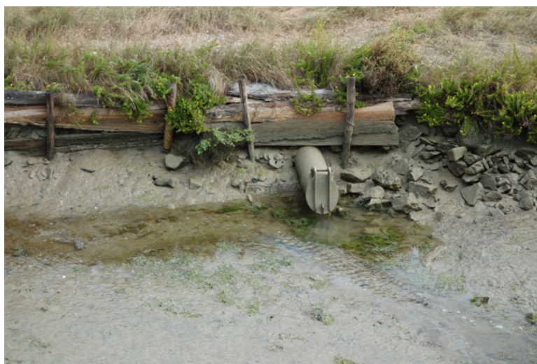
FIGURE 1.12 – Photo d'une buse avec un clapet (île de Noirmoutier). ©Léo Guiot.
