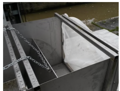
FIGURE 4.7 – Photo de la zone 5 du canal in situ , vue de coté. ©OFB.
