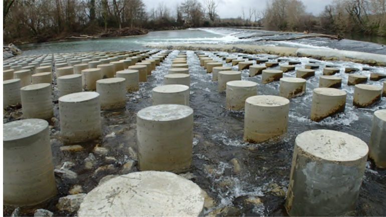
FIGURE 1.9 – Photo de la passe à macrorugosités de Sordes sur le Gave d'Oloron. ©OFB.
