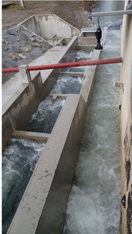
FIGURE 1.8 – Photo de la passe à bassins à l’usine d’Auterrive sur le Gave d’Oloron. ©OFB.
