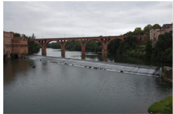
FIGURE 1.2 – Photo d'un seuil sur Le Tarn (Albi). ©Léo Guiot.
