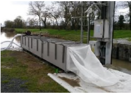
FIGURE 4.2 – Photo du canal in situ , vue de l'aval). ©OFB.
