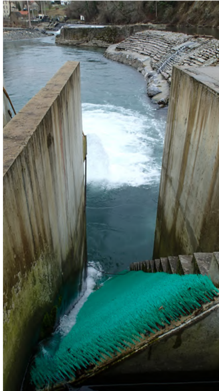
FIGURE 1.10 – Photo de la rampe à reptation de l’usine de Masseys sur le Gave d’Oloron. ©OFB.
