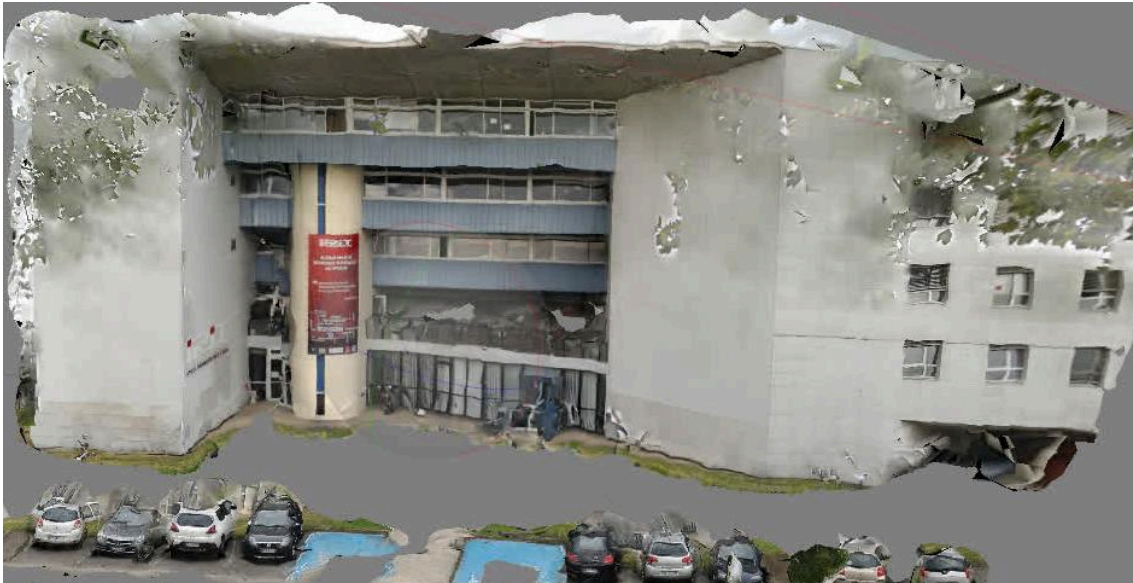
FIGURE 1.4 – Reconstruction 3D de la façade de l’IRIT obtenue en ajoutant aux vues présentées sur la figure 1.2 la vingtaine de photos de la figure 1.3.
