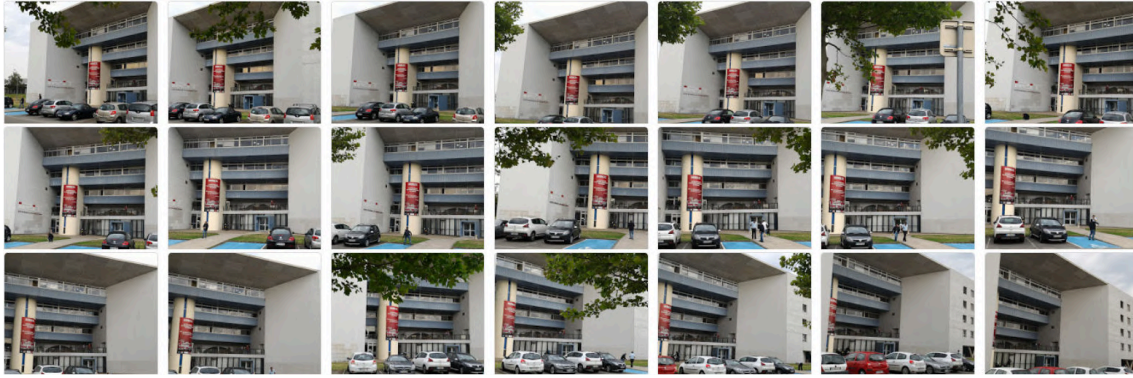
FIGURE 1.3 – Photos supplémentaires — En plus des vues de la figure 1.2, nous avons pris une vingtaine de photos de la façade du bâtiment à des positions et selon des orientations proches.
