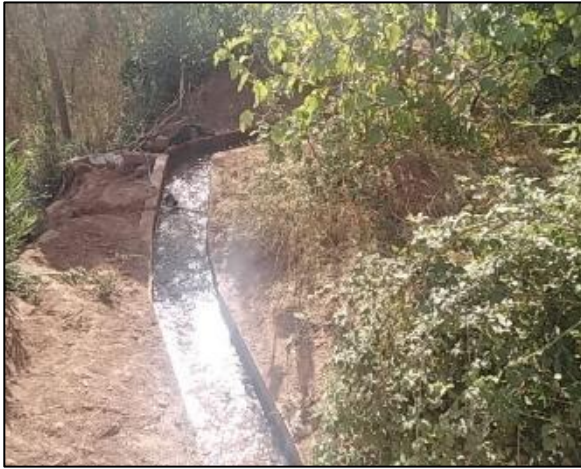
Figure 2-8: Seguia en béton en fonction
