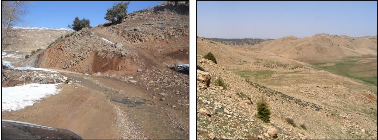
Figure 1-20: Sommets d'Assif Zad dégradées par l'érosion hydrique
