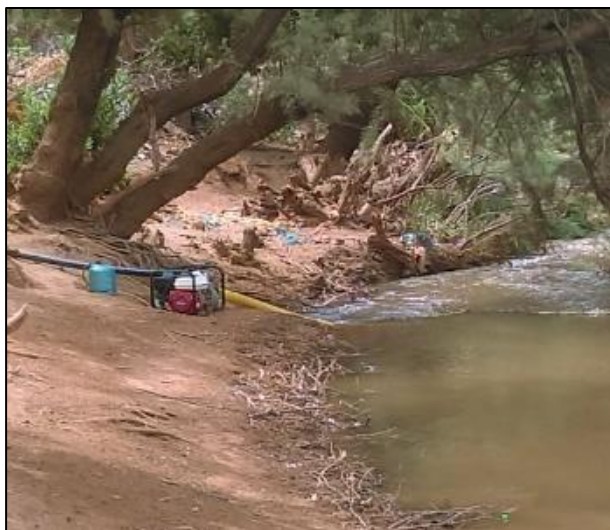
Figure 2-10 : Pompage direct de l'oued de Chbouka
