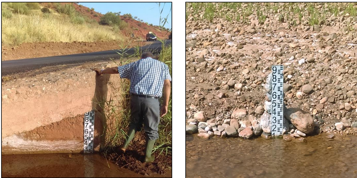
Figure 10-6 : Echelle limnimétrique installée sur l'oued de Srou et sur l'affluent Assif N'douma
