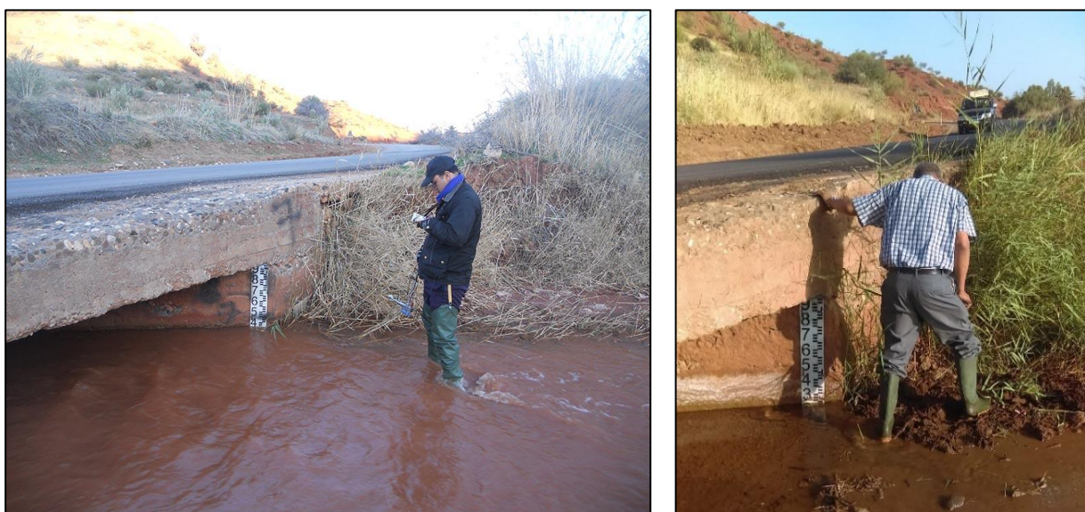
Figure 10-11 : Mesure du débit et de la hauteur d'eau dans les hautes eaux (janvier 2018) et les basses eaux (août 2017) (station d'Assif N'douma)
