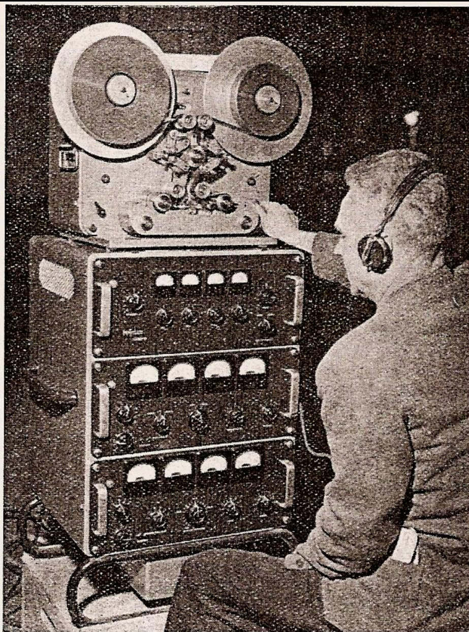
MACHINE D'ENREGISTREMENT STEREOPHONIQUE QUATRE PISTES. — En haut : Les quatre indicateurs de polarisation. — Au milieu : Les appareils indicateurs de volume à l'enregistrement. — En bas : Les appareils indicateurs de volume enregistré.
