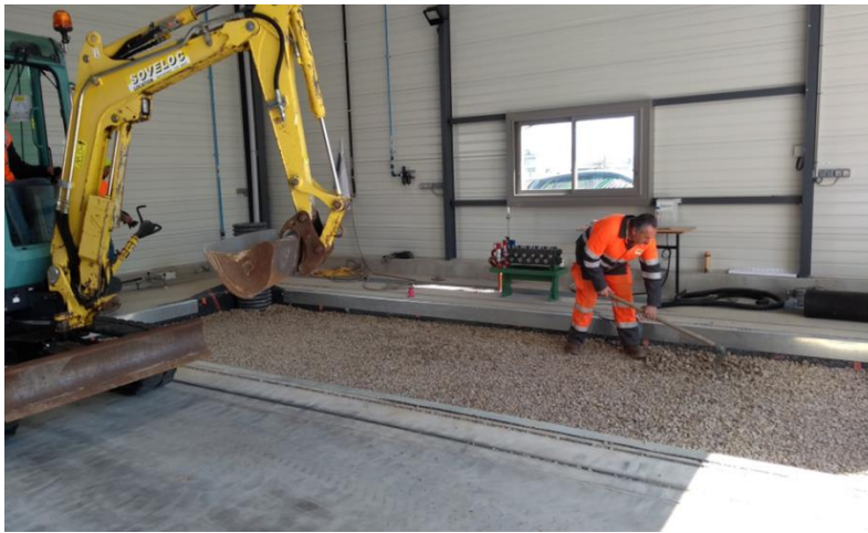
Figure 118 Remplissage de la fosse (gauche) et l'essai de plaque (droite)
