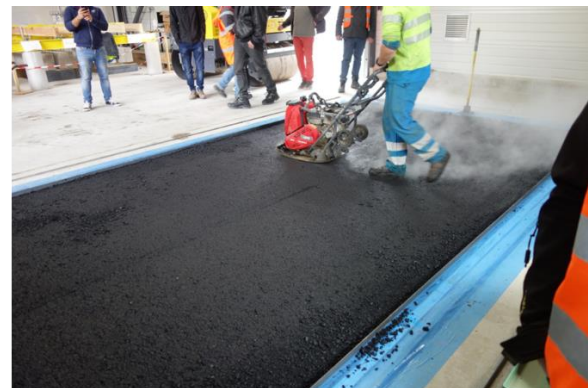
Figure 119 Mise en œuvre de la couche de GB \epsilon + dans la fosse
