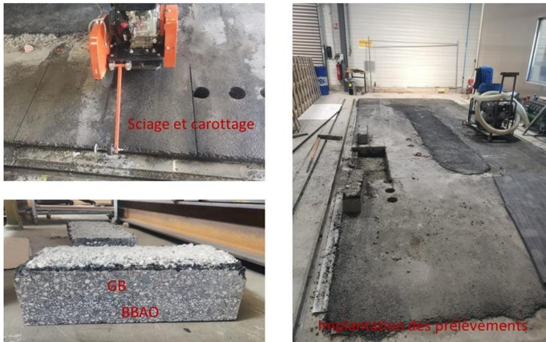
Figure 73 Découpage des plaques d'enrobé
