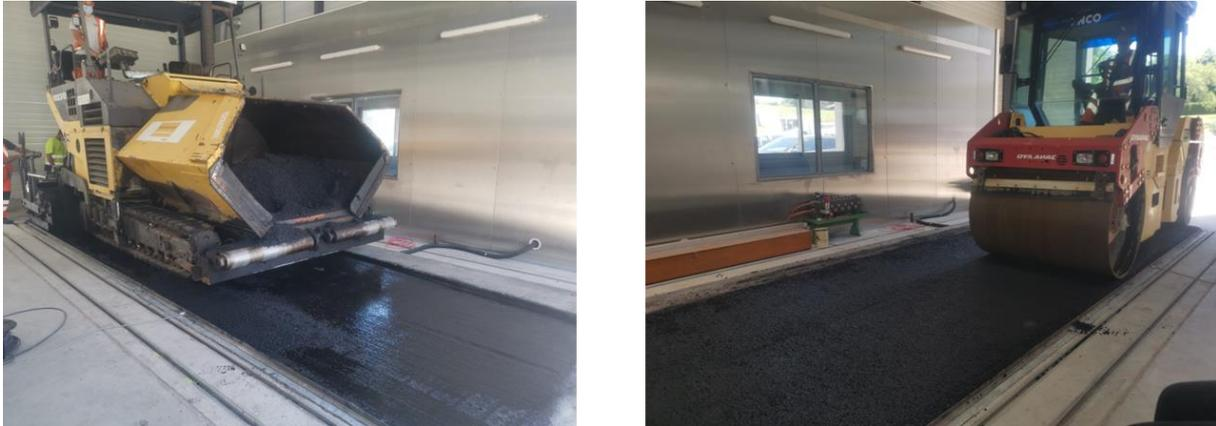
Figure 120 Mise en œuvre du BBAO+
