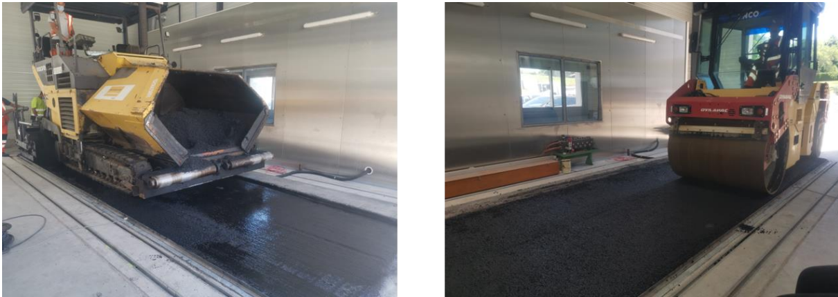
Figure 120 Mise en œuvre du BBAO+
