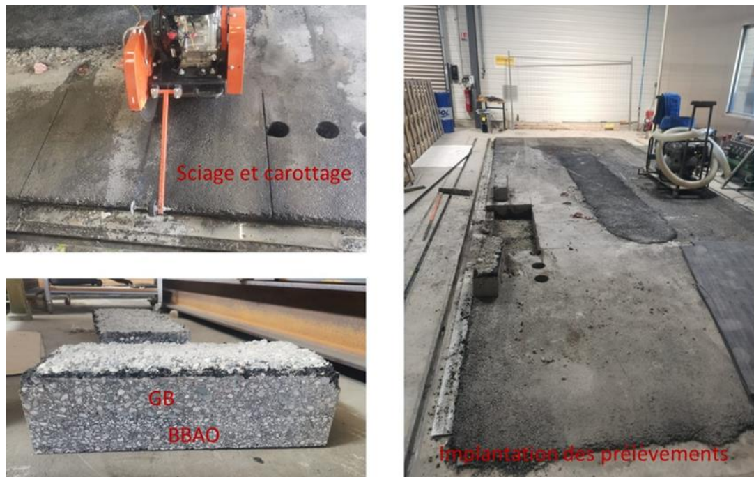
Figure 73 Découpage des plaques d'enrobé
