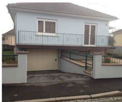
La clôture après transformation (source : NF, 2014-2020)
