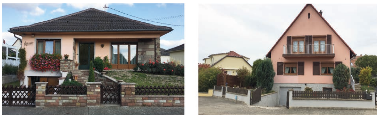
Fig. 6.13. Des choix esthétiques associant la maison avec la clôture
