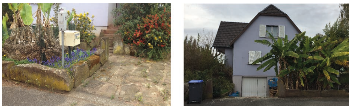
Fig. 4.8. La clôture d'Emmanuel, faite de blocs de grès récupérés
