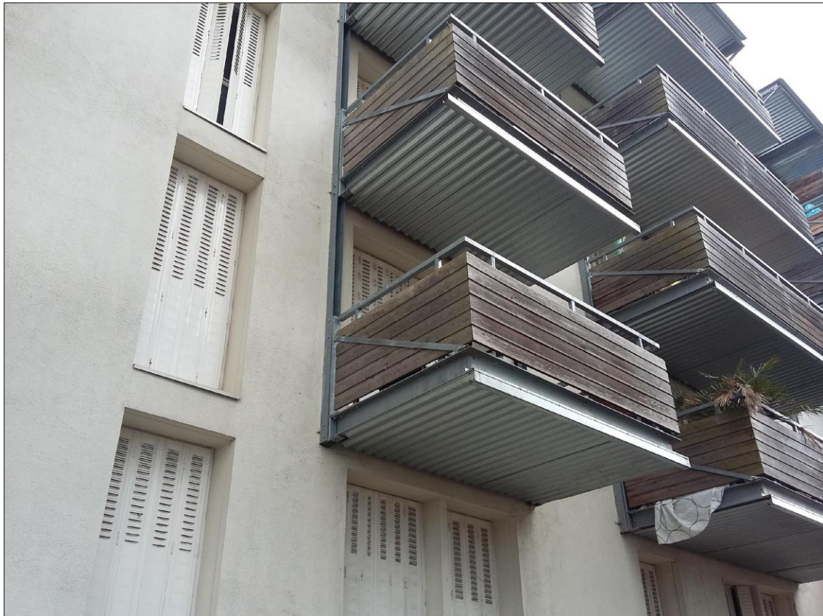
Figure 32. Ajout de balcons sur la façade d'un bâtiment existant. Source : Photo de l'auteure 2018.
