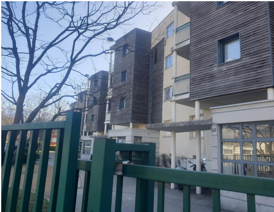
Figure 54. Résidentialisation d'un îlot dans le quartier Teisseire.
