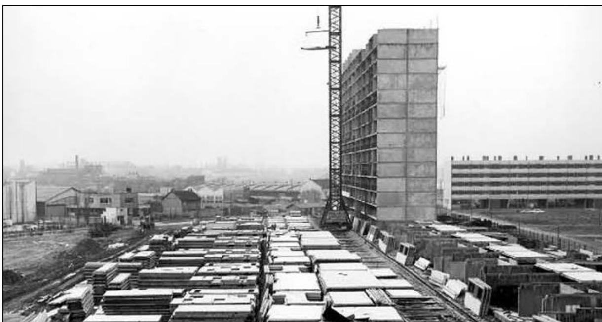
Figure 6. Chantier de construction des « 4 000 » à la Courneuve.
