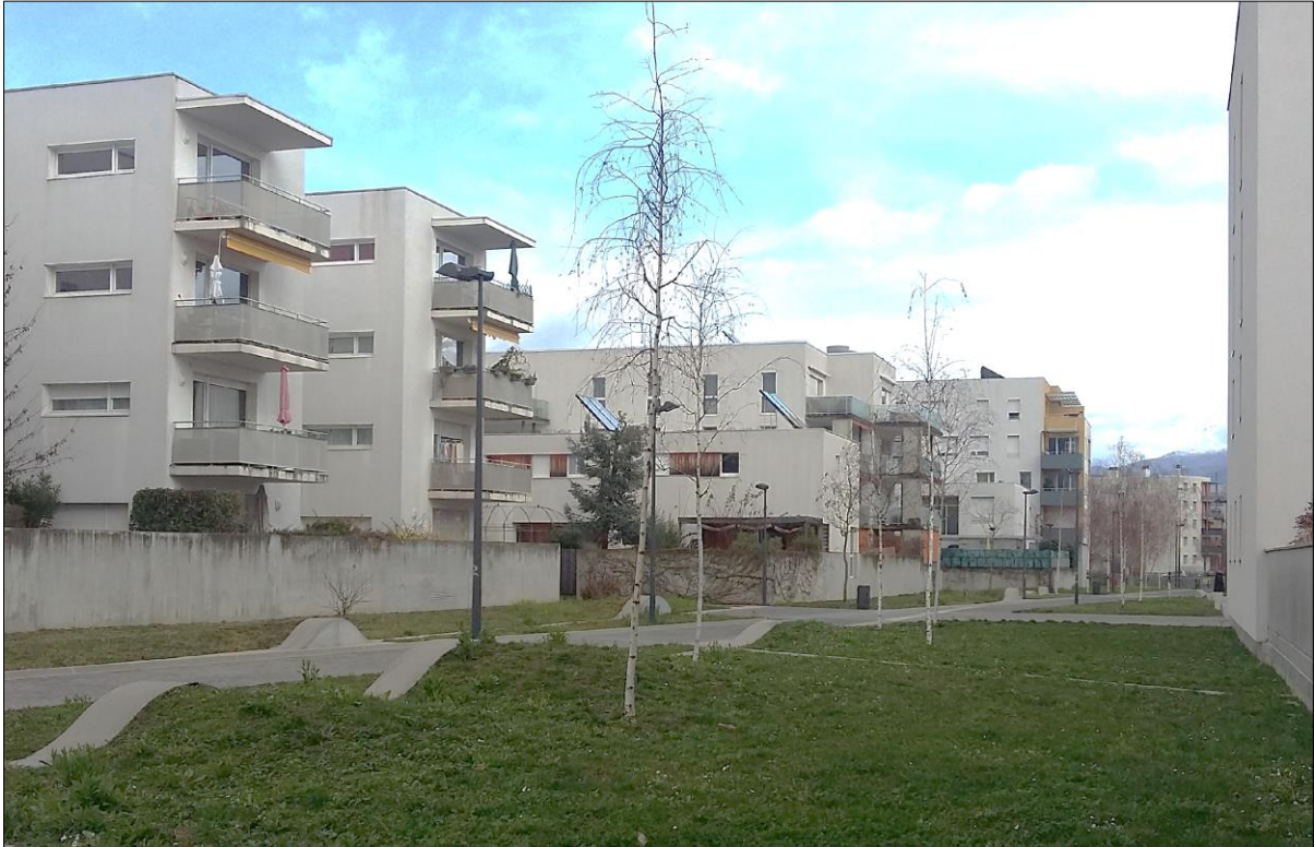
Figure 35. Constructions de logements neufs dans la ZAC J.O-Teisseire. Source : photo de l'auteure (2018)
