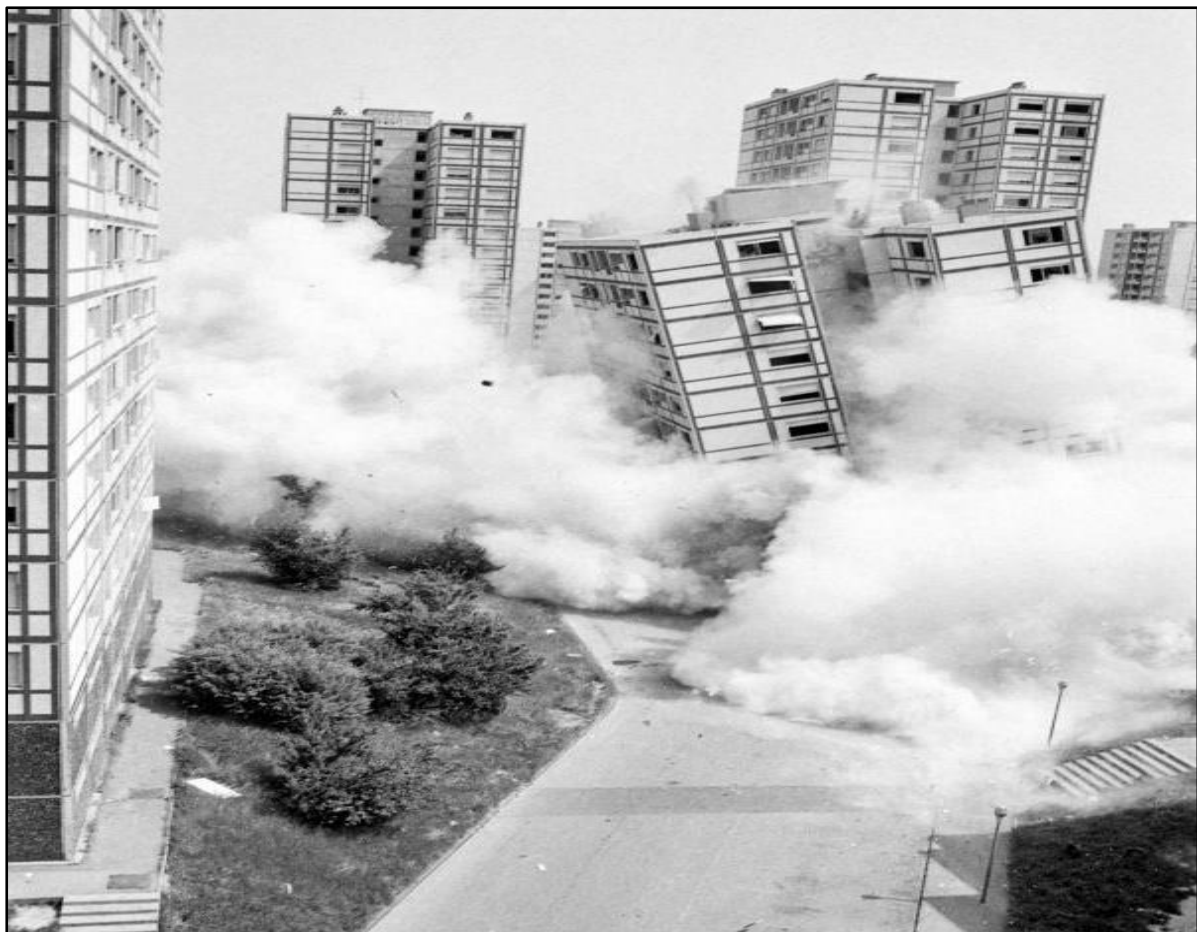
Figure 15. Démolition de la Tour 6 des Minguettes à Vénissieux le 9 juin 1983.
