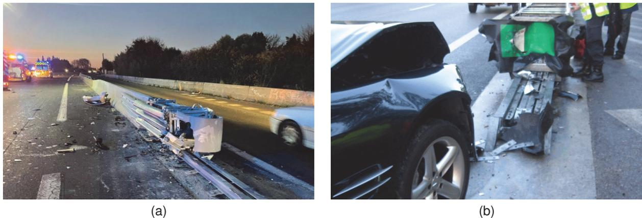
FIGURE 1.1 – Photographies d'accidents de la route sur atténuateurs de chocs
