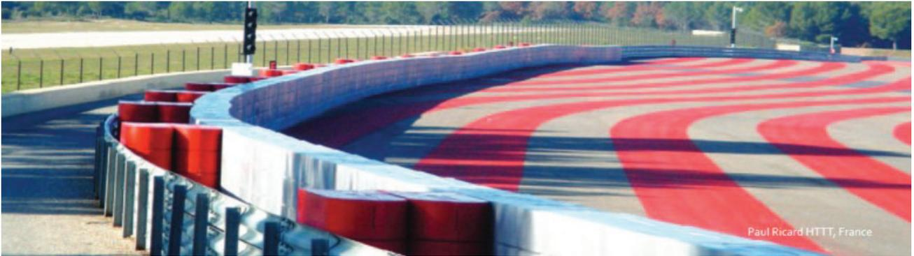
FIGURE 2.7 – Barrières de sécurité de la société TecPro installées sur le circuit automobile Paul Ricard, France.
