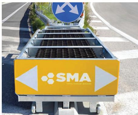
FIGURE 2.5 – Photo d'un atténuateur de choc SMA sur une portion d'autoroute [20].
