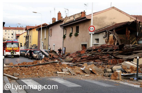
(b) Effondrement par perte de stabilité
