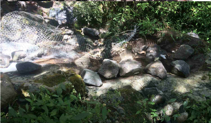
Figure 89: Captage maron réalisé avec une couverture de grillage pour poullailler et pierres, Marla, Nicault M., 2019
