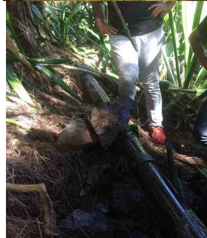
Figure 94: Canalisation fracturée par un glissement de terrain, Roche-Plate, réparée avec les moyens du bord, Nicault M., 2019.
