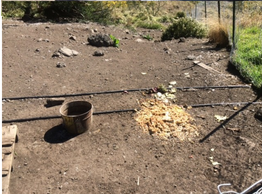
Figure 92: Conduites traversant un poulailler, Marla, Nicault M., 2019.
