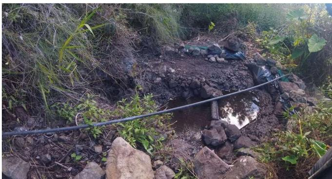
Figure 90: Captage maron avec crépine et installation de bâches et rochers avec présence de sédiments et matières organiques au sein du captage, Roche-Plate, Nicault M, 2019
