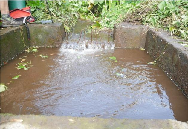
Figure 87: Absence de couverture de la prise d'eau, avec présence importante de sédiments et de matière organique en décomposition en contre bas d'un talweg, Roche-Plate, Lallemand J., 2018.
