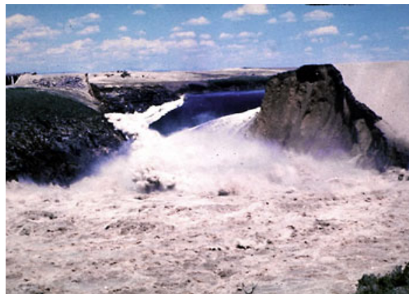
(b) La rupture du barrage de Teton en 1976 aux États-Unis, image Wikipédia.
