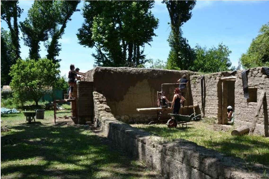
Fig. 4 Stage expérimental de restitution d'une maison gauloise à Lattes (Musée Henri-Prades) en juin 2018 (F. Mourot)
