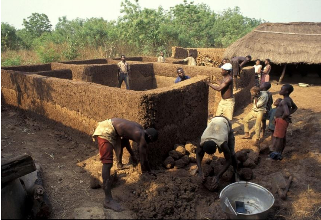
Fig. 49 construction d'une maison en bauge au Bénin (Photo T. Joffroy) 13
