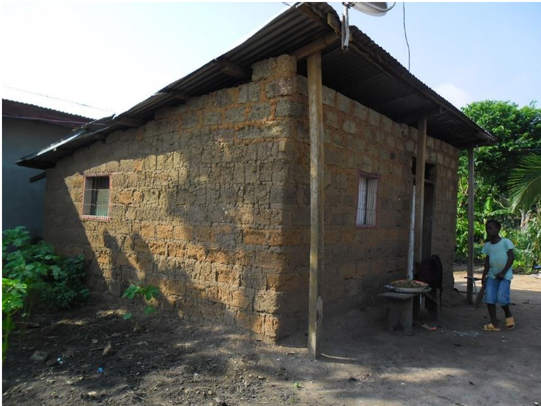
Fig. 49 construction d'une maison en bauge au Bénin (Photo T. Joffroy) 13
