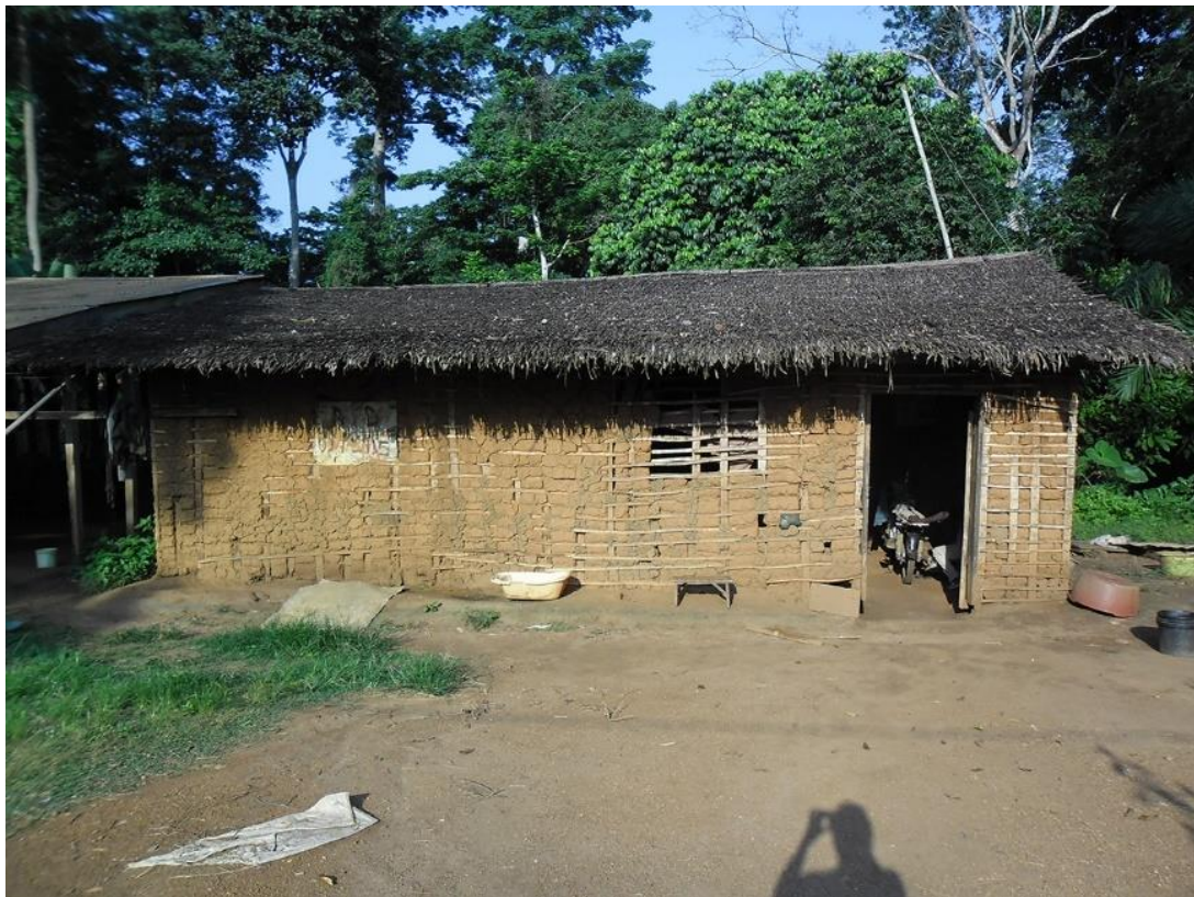
Fig. 48 Maison en terre de garnissage sur poteaux porteurs, Batchenga, Cameroun (Photo M. Marcel, 2018)
