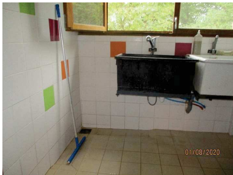
Figure 22: Evacuation de l'eau en fromagerie
