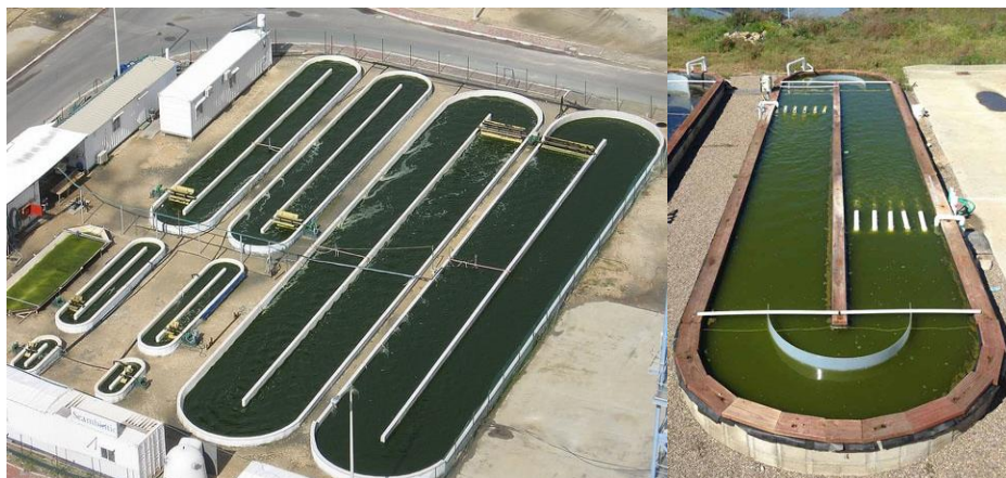
Figure 11. Chenaux à haut rendement algal en Israël (Kloosterman, 2011) et en Californie (Fields et al., 2021)
