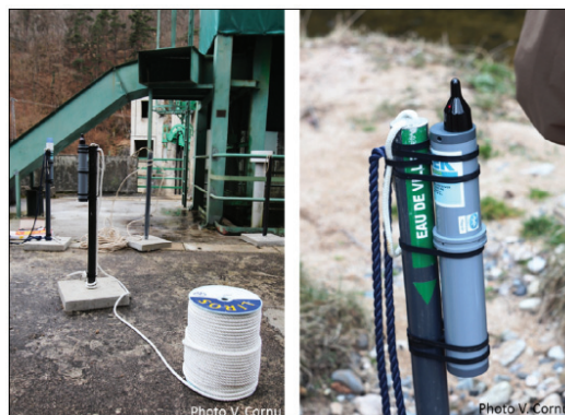
FIGURE 2.8 – Installation des hydrophones sur leur ancrage béton. A droite, zoom sur l'hydrophone en place sur le mât en PVC (Tetard et al., 2016).
