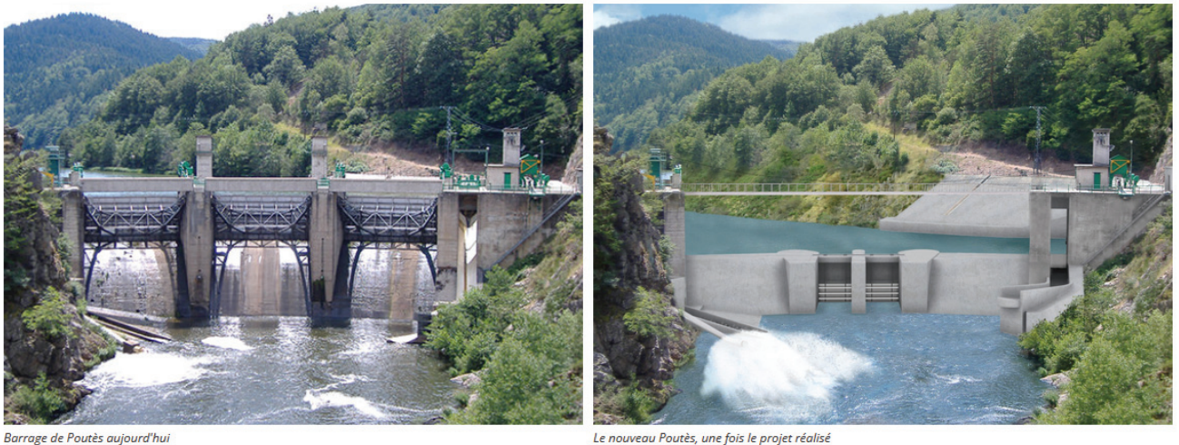
FIGURE 2.6 – Vue aval du barrage de Poutès : avant/après. Source : https://www.nouveau-poutes.fr/
