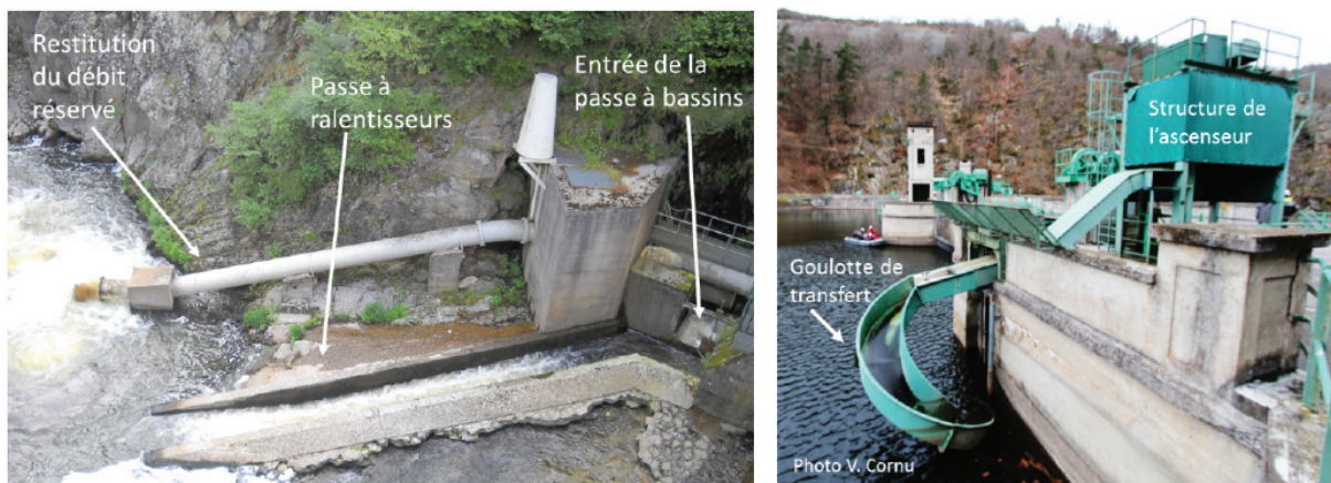
FIGURE 2.4 – Passe à ralentisseurs à l'aval et structure de l'ascenseur vue de l'amont avec sa goulotte de transfert (Tetard et al., 2016).
