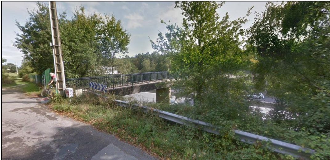
Fig. 8 : Photographie : Vue de la rocade depuis le chemin de la Taupinais, orientation N/O (2020)
