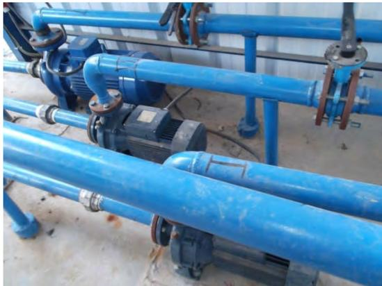
Figure I.2.8 : Le groupe des électropompes du grand canal de l'INAT
