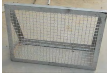
Figure I.2.7 : Grillage utilisé pour fixer les enrochements dans le grand canal de l'INAT
