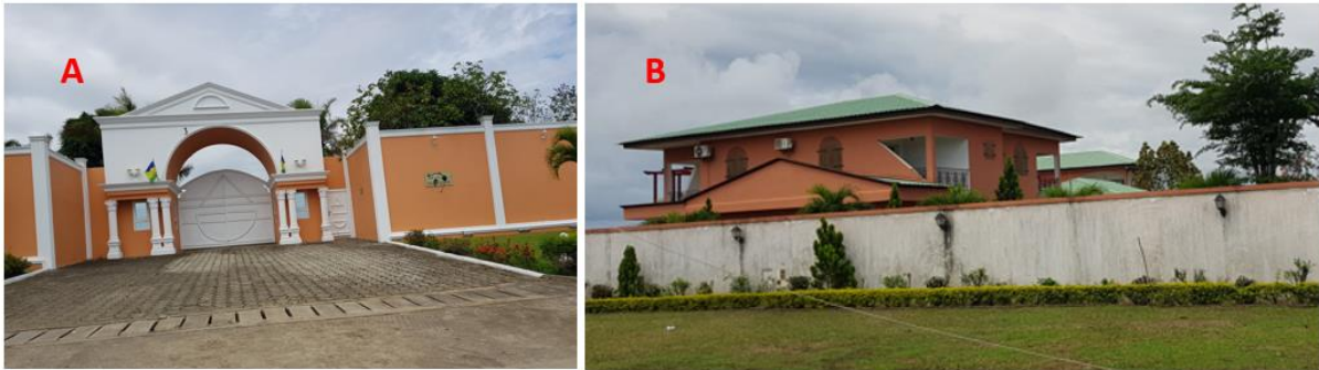
Planche 2 : Logement haut standing dans la périphérie nord de Libreville à Avorbam (Akanda) (Source : Biboutou, 2022.)
