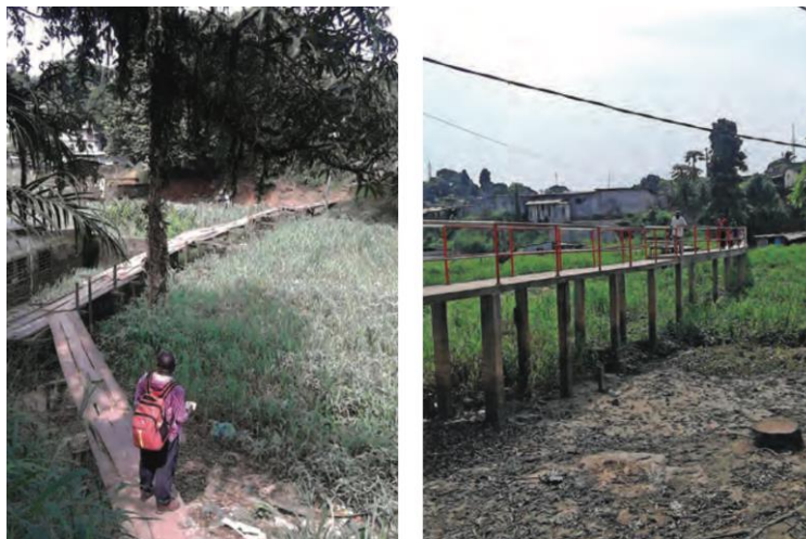
Planche 11 : Passerelles rudimentaires d'adaptation aux inondations. ( Ménié Ovono, 2016.)
