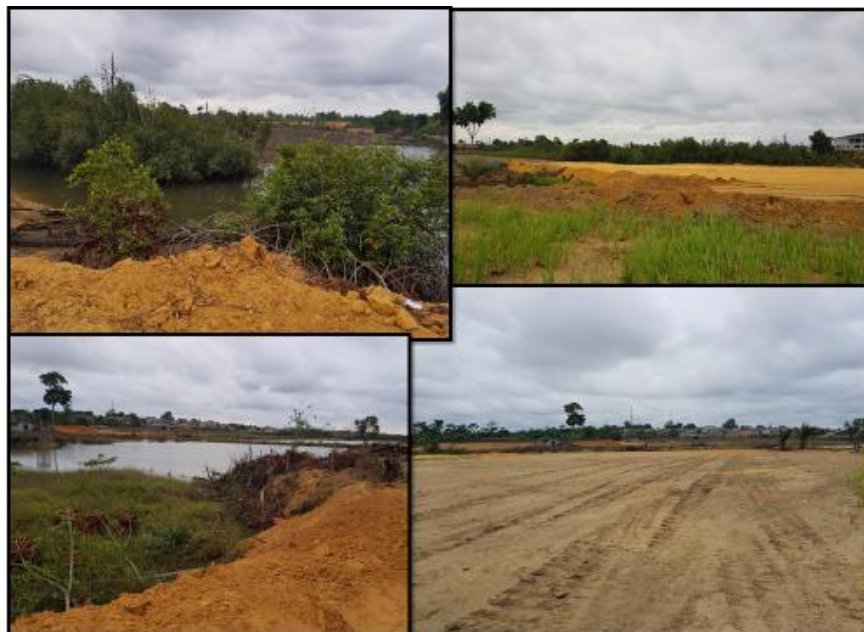
Planche 6 : Coupe et Remblai de la mangrove à Angondjé, ( Biboutou, Route du Cap caravane Angondjé, 2018)
