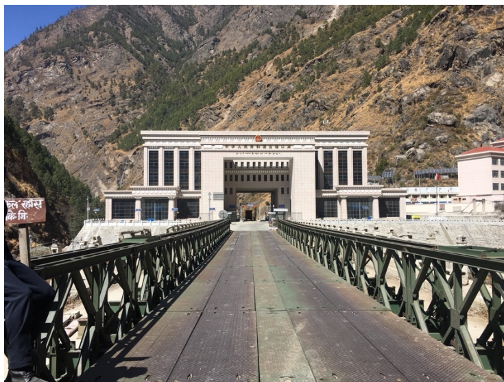
PHOTO 21 : LE BATIMENT DES DOUANES CHINOISES AU BOUT DU PONT AU-DESSUS DE LA FRONTIERE
