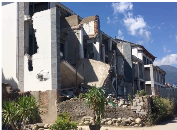
PHOTO 47 : UN HOTEL SUR LA RIVE DU LAC WENHAI EN COURS DE DEMOLITION
