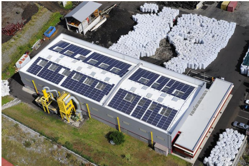
Figure 2.6 Centrale PV COREX de la Possession vu d'en haut
