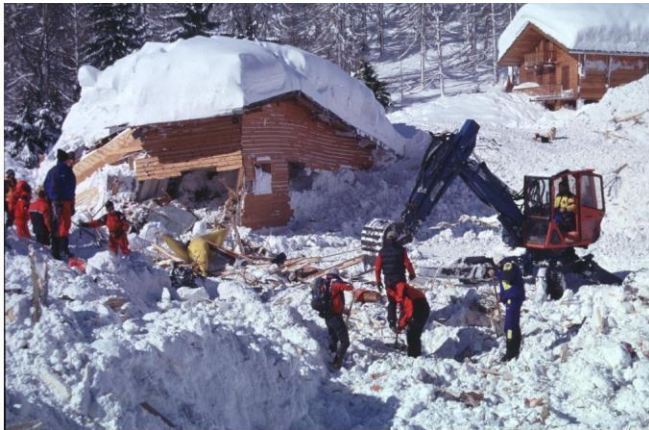
Figure 1 : Dégâts causés par l'avalanche de 1999, à Montroc. Source : (Rapin et Ancey, 2000).
