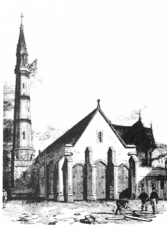
Figure 32 : Le bâtiment des machines à Forest Hill sur la ligne de Croydon Source : Croydon Public Library .
