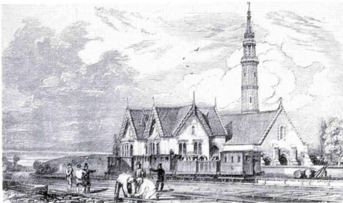
Figure 31 : La gare de Forest Hill sur la ligne de Croydon, avec le bâtiment des machines et sa cheminée derrière Source : Croydon Public Library .
