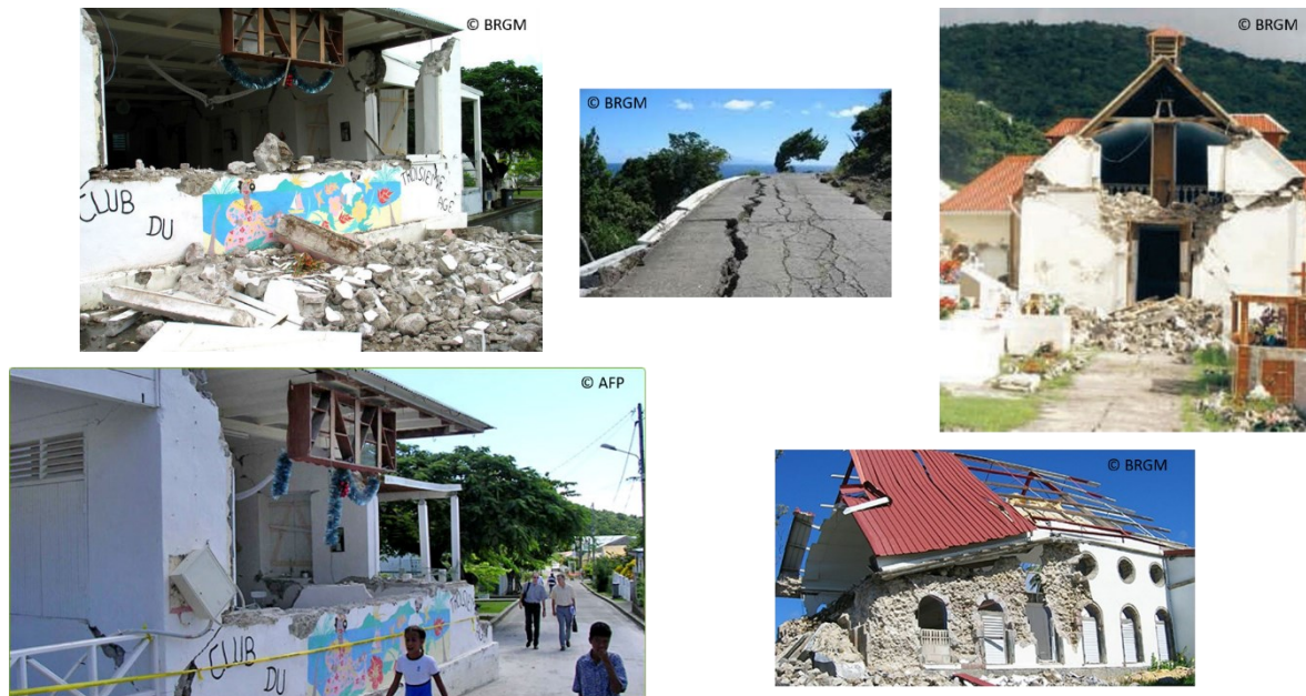
Figure 2 - Exemples de dégâts structurels liés au séisme des Saintes de 2004.
