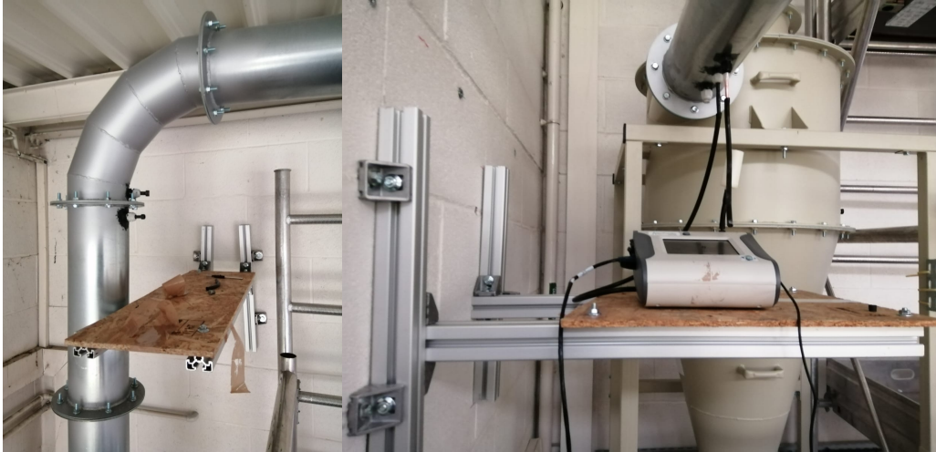
FIGURE 3.35 – Points de piquage pour les mesures de granulométrie.
