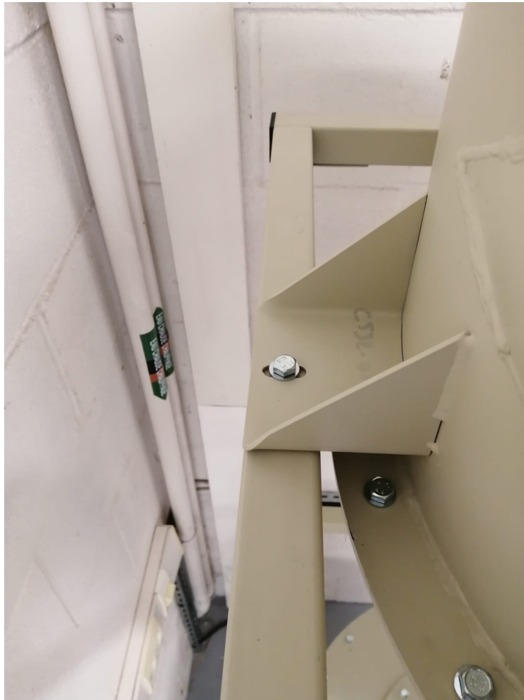
FIGURE 3.99 – Connection de la chaise avec le corps de cyclone à l'aide de sabot soudé.
