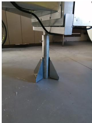
(b) Support du caisson filtrant en sortie.
