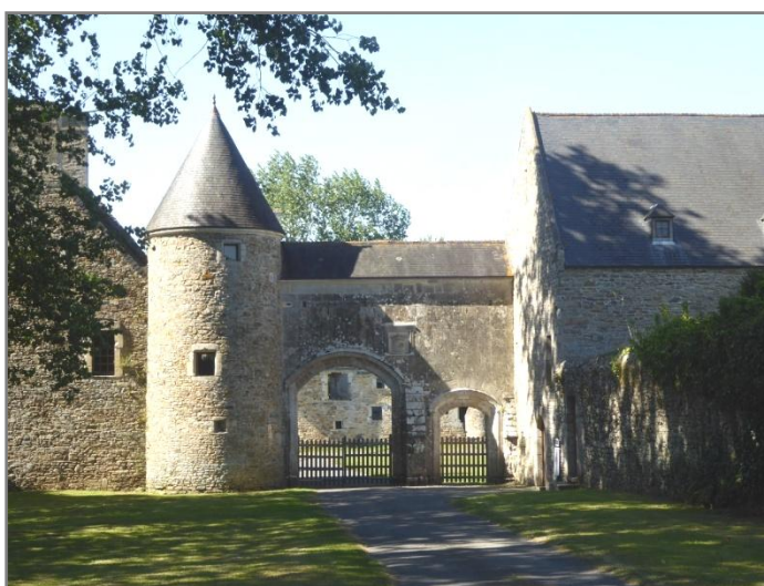
Figure 12 : Porterie du château de Montfort
