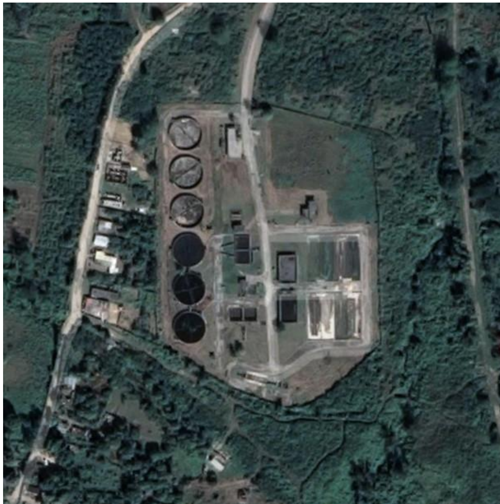
Figura A1. Planta de tratamiento de aguas residuales municipales, "María del Carmen" Boyeros, la Habana, Cuba, (23°02'24.3"N 82°24'30.0"W).
