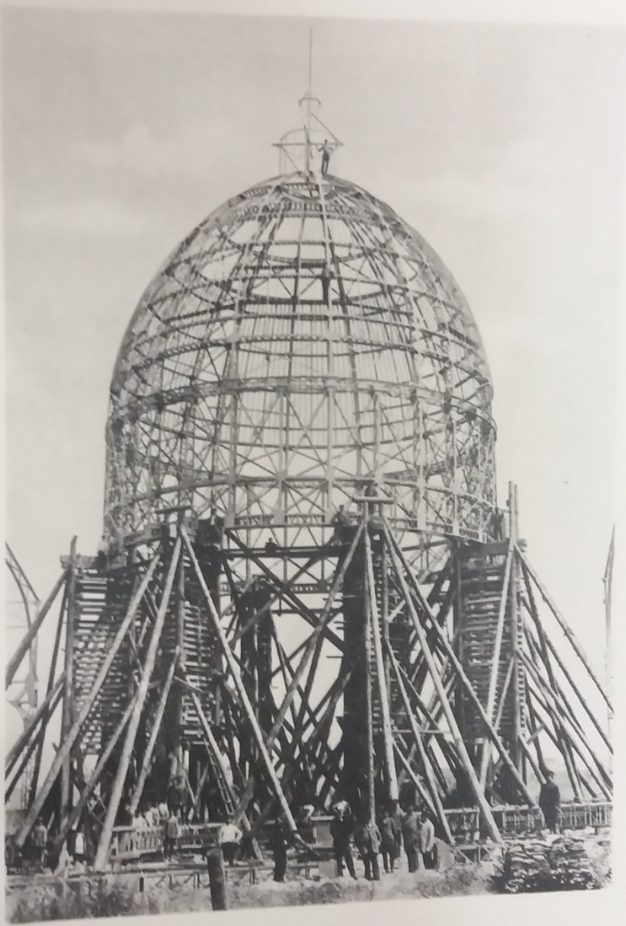
Constructions métalliques Dôme central du Palais des Beaux Arts à l'Exposition de Nijni-Novgorod en 1896.
