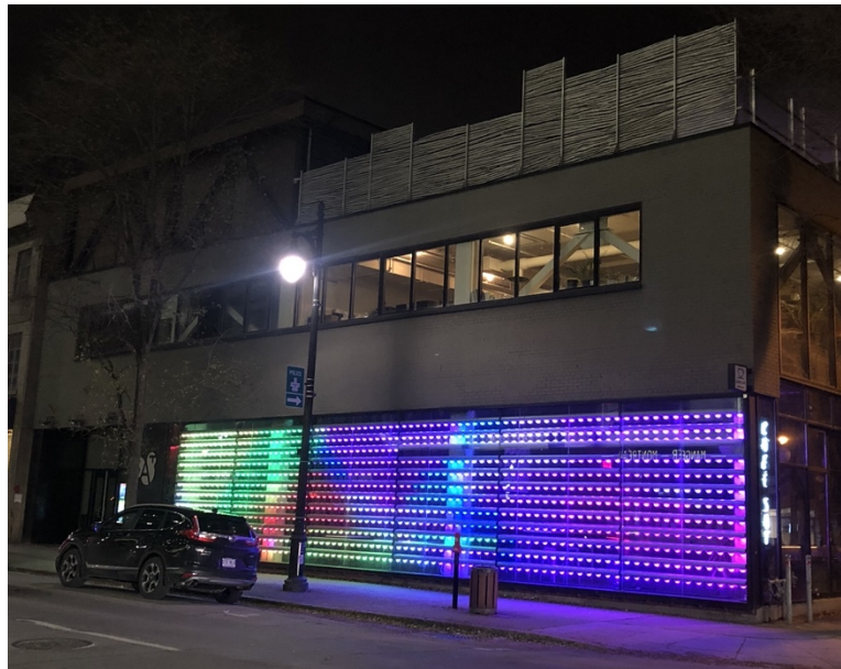
Figure 51 - Prise de vue de l'extérieur de la SAT, dont la façade offre un mapping à partir de LED. (Source : auteur).
