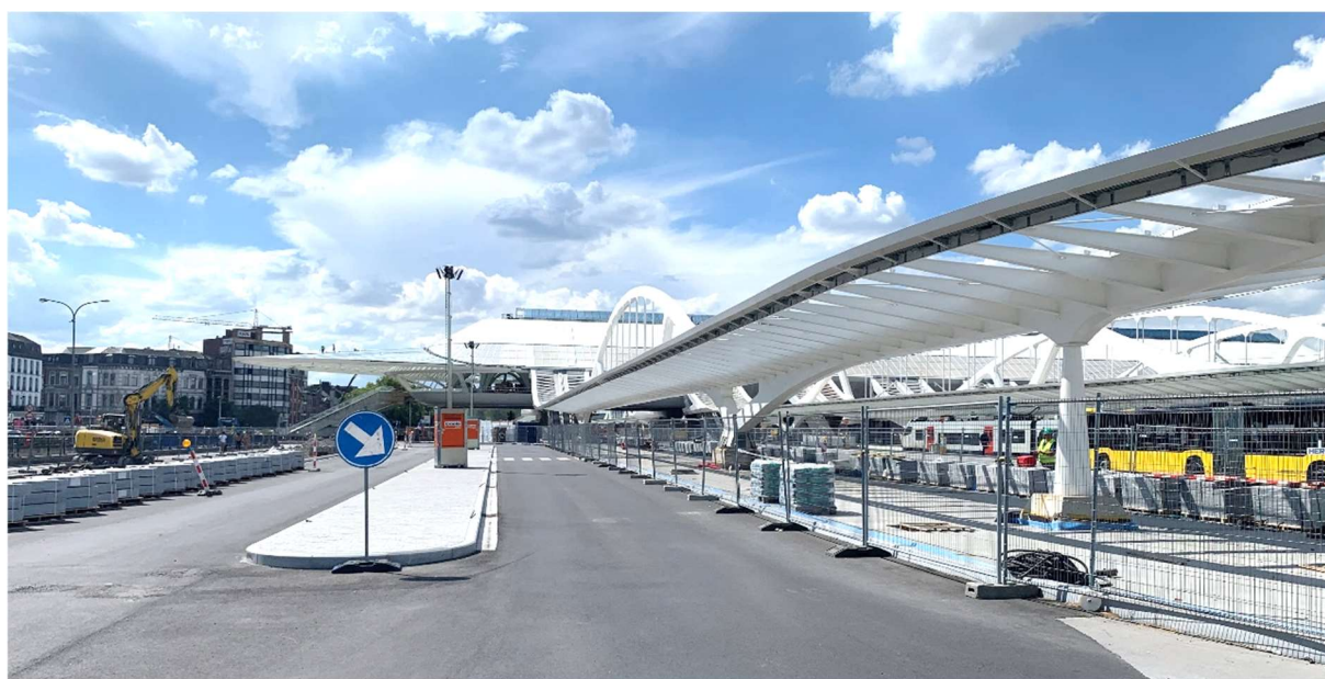
FIGURE 71 : GARE MULTIMODALE DE MONS EN TRAVAUX. PHOTOGRAPHIE DE DURIEUX, AOÛT 2022
