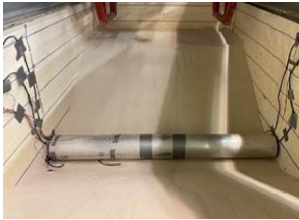
Figure 3-20 Photo de la canalisation dans la tranchée avant remblaiement
