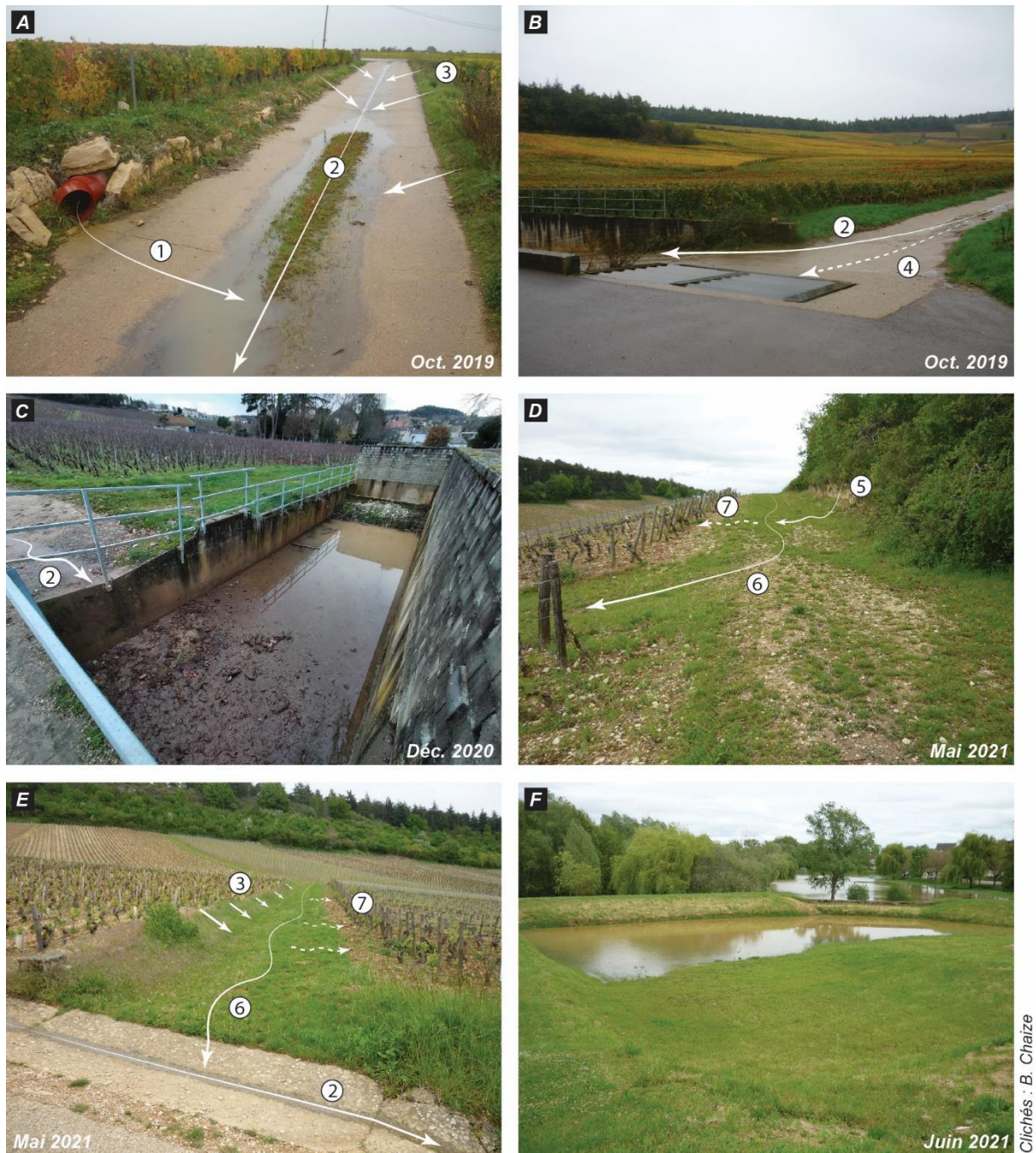
Figure 2.7 : Infrastructures hydrauliques pour la gestion des flux hydro-sédimentaires au sein du vignoble de Mercurey. (A) Connexion directe entre une conduite souterraine et une chaussée en béton incurvée en « V » ; (B) Bassin décanteur en sortie de sous-bassin versant viticole alimenté par une chaussée en béton incurvée en « V » ; (C) Décantation des eaux chargées en sédiments ; (D) Chemin d'exploitation transversal en haut de versant ; (E) Chemin d'exploitation transversal à mi-versant ; (F) Bassin d'orage (premier plan) et retenue artificielle du Pont Latin (arrière-plan) séparés par une digue de surverse.
