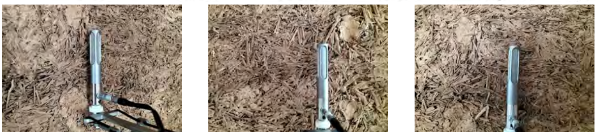
Figure 314 Mesures in situ du coefficient d'absorption acoustique par fréquence et photographies de la mesure. Mur en terre et chanvre (terre allégée) – Baulon.
