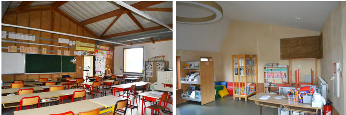
Figure 15 Mur de refend en torchis (classe) et mur en terre allégée (bibliothèque).
