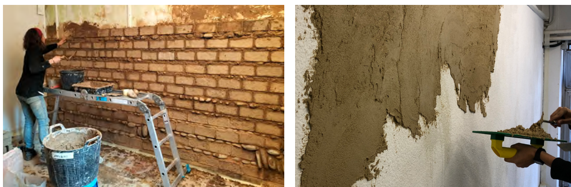
Figure 231 Mise en œuvre Grenoble (briques) et Barcelone (enduit)
