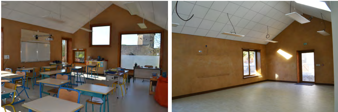
Figure 19 Murs en terre allégée et enduit terre sur supports bottes de paille.
