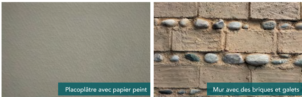
Figure 22 L'avant et l'après de la finition de la salle.
