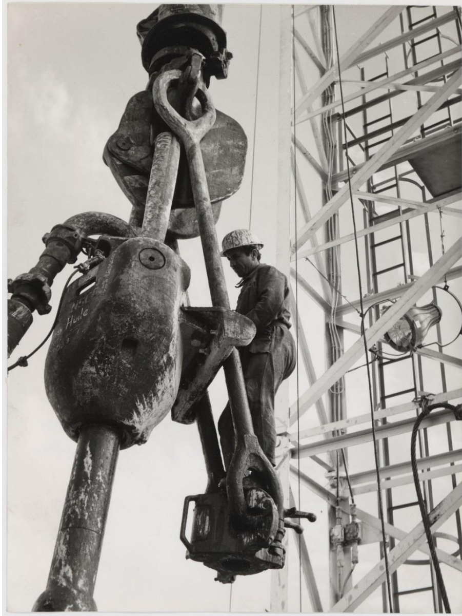
Photo 31: Ouvrier sur l'appareil de forage IDECO 2500 diesel à Haoud Berkaoui-Ben Khala, 1967 - Photothèque Historique Total, 17V00537-14-2, Dimitri Dimka©
