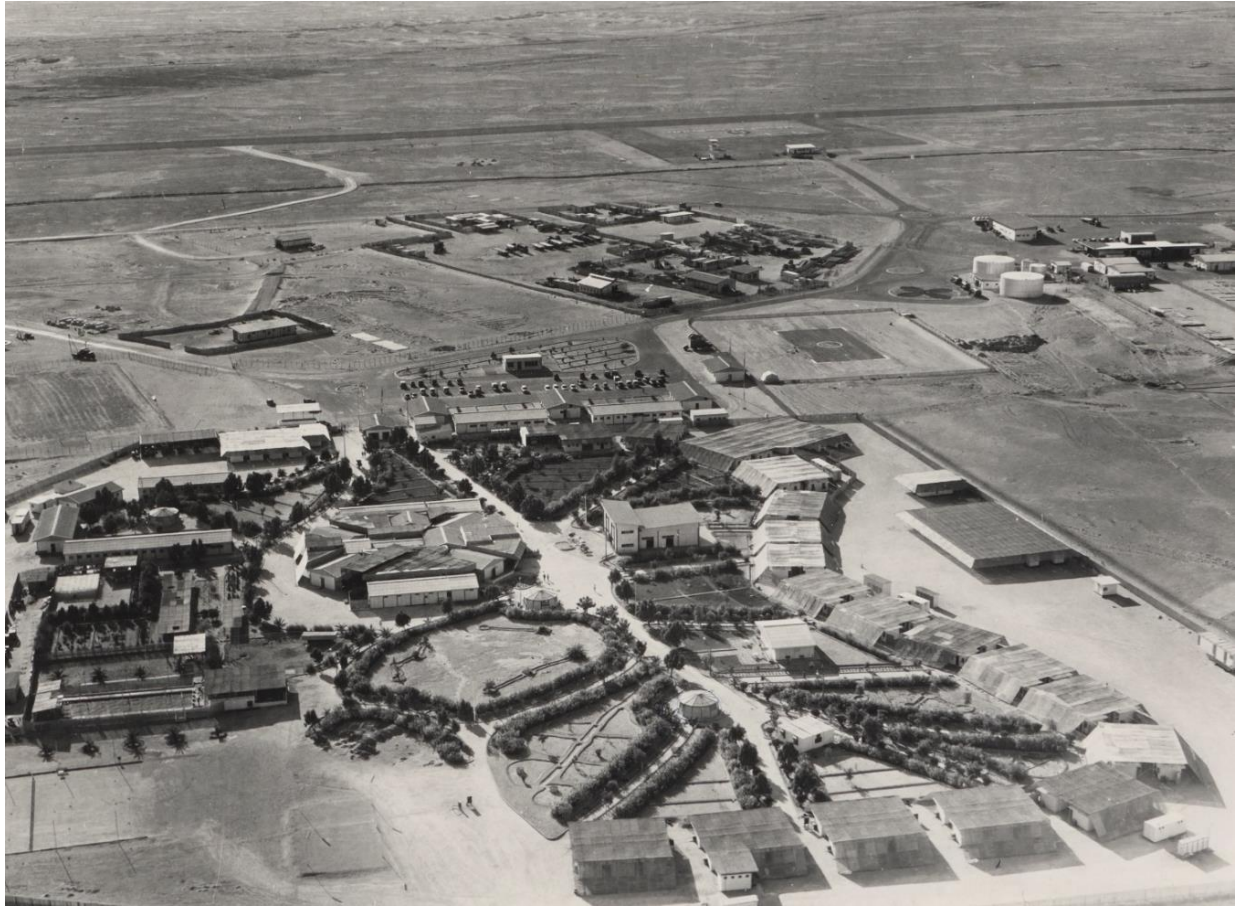
Photo 16: Vue aérienne de la base Maison Verte et ses installations, 1961 – Photothèque Historique Total, 17V00537-40-2, Grevin S.T.E.P.- J.©
