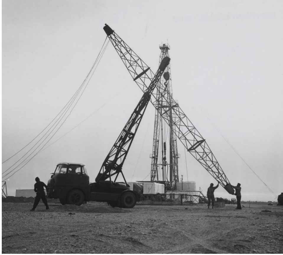
Photo 9 : Installation de l'appareil de forage Emsco J 1400 à El Goléa, 1954 – Photothèque historique Total, 17V00537-78-1.
