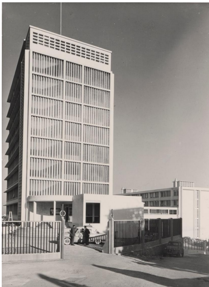
Photo 20: Siège de la CFP-A dans le quartier Hydra à Alger, 1959 – Photothèque Historique Total, 17V00538-436-1, Droits Réservés - Total ©
