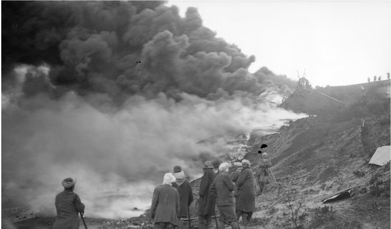
Photo 3 : Incendie du puits TS 26 à Tselfat, 1934 - Photothèque Historique Total, 98.01/7, Willy Bruderer©
