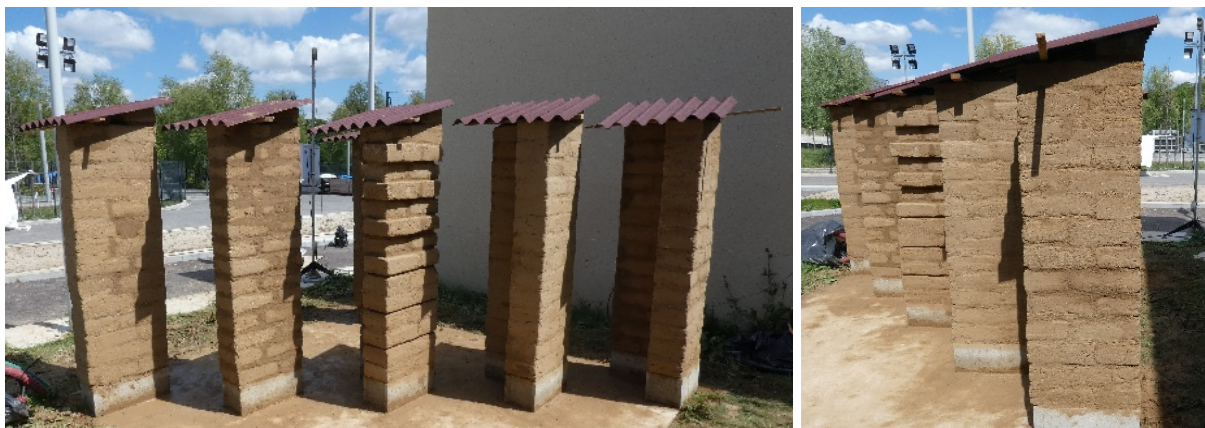
Figure 6. 8 : Murs terminés après trois jours de chantier ; à gauche, vue des façades ouest et sud ; à droite, vue des façades sud
