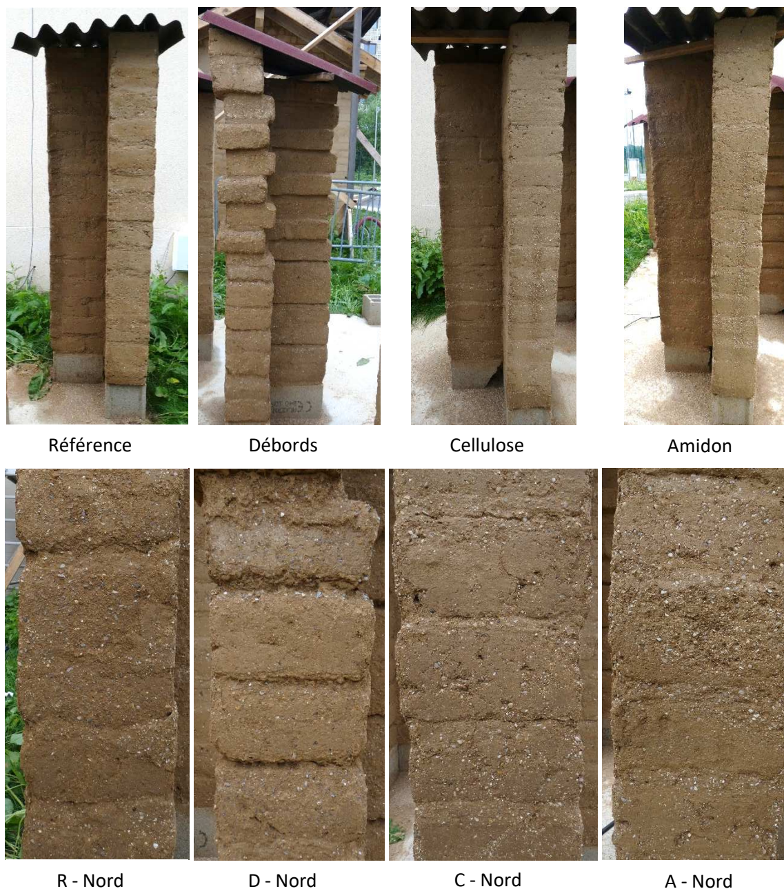
Figure 6. 10 : Aspect des murs 48 jours après le chantier
