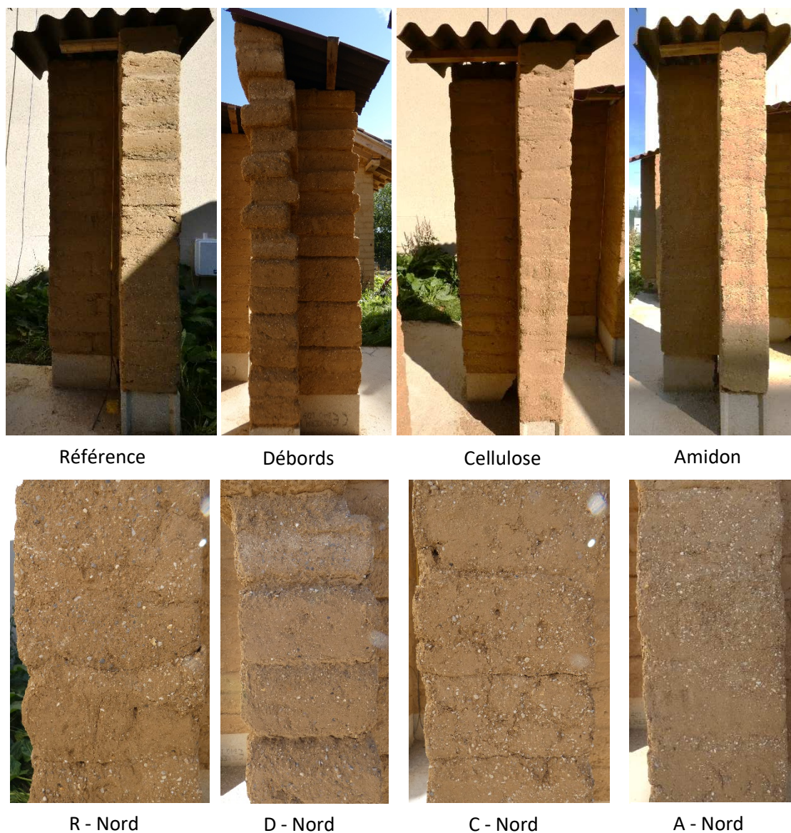
Figure 6. 11 : Aspect des murs 139 jours après le chantier
