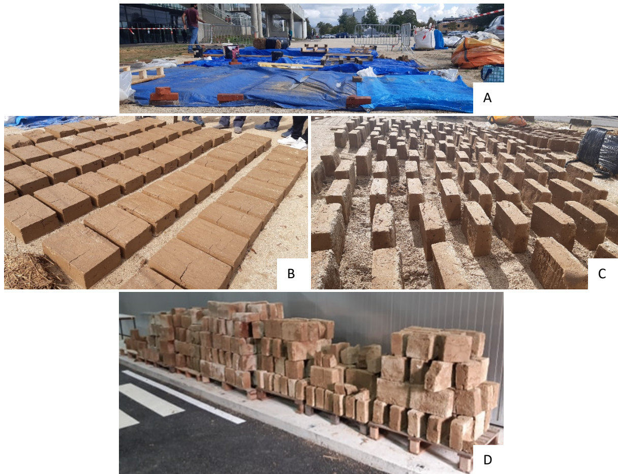
Figure 6. 3 : Étapes de séchage. A : protection contre la pluie des briques par des bâches ; B : briques après un mois de séchage sous les bâches, des fissures sont apparues en surface ; C : séchage des briques sur champs ; D : séchage des briques sur palettes en intérieur.
