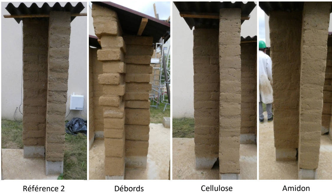
Figure 6. 9 : Aspect des murs 11 jours après le chantier
