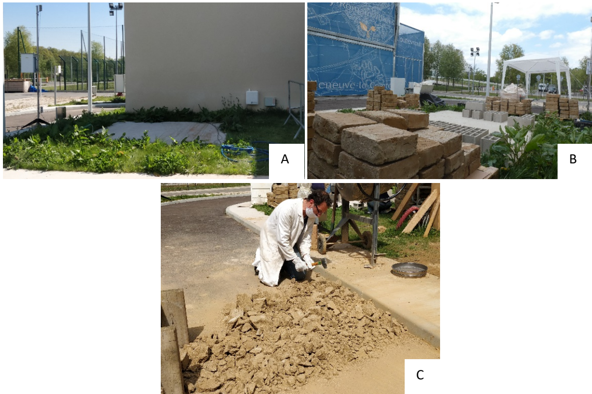
Figure 6. 4 : Organisation du chantier. A : Emplacement vide sur le site de l'Equipex Sense City ; B : Répartition des briques en fonction de l'emplacement des murs ; C : Préparation du mortier par concassage des briques inutilisables structurellement.
