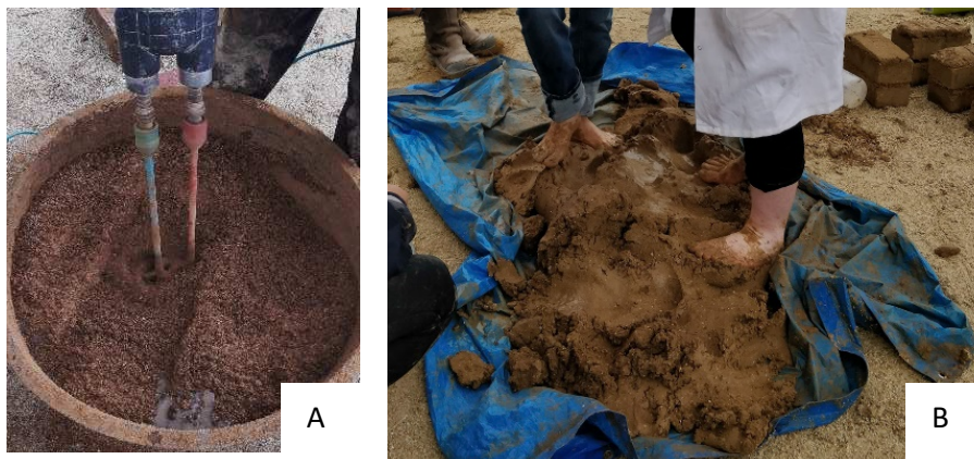
Figure 6. 1 : Étape de mélange des produits. A : utilisation d'un mixer ; B : utilisation d'une bâche pour mélanger avec les pieds.
