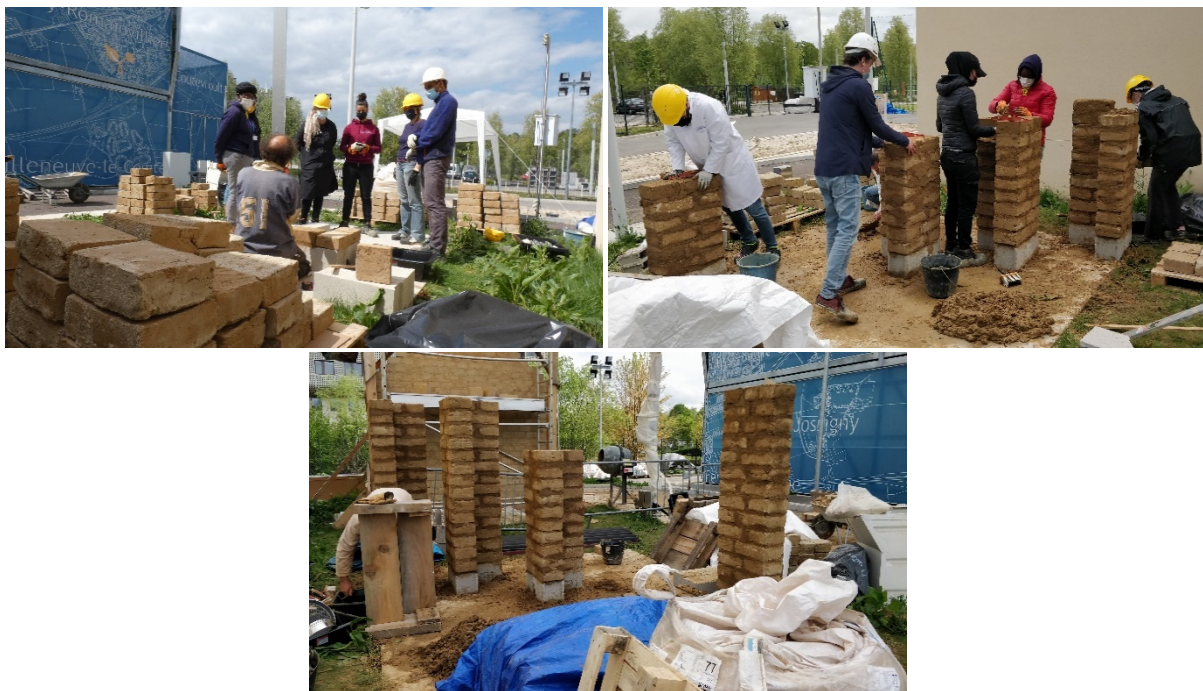
Figure 6. 6 : Construction des murs à différentes étapes
