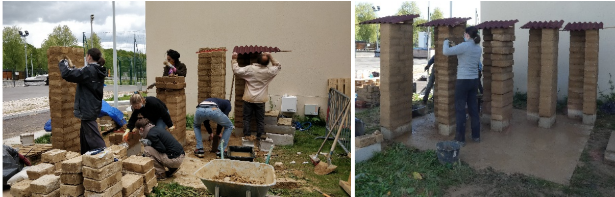
Figure 6. 7 : Fin de la construction des murs, montage du toit et finitions
